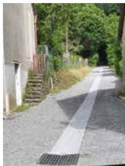
Les travaux de réfection de l'écoulement des eaux de pluie et de la chaussée, débutés fin 2019, ont été interrompus à cause des intempéries et ensuite de la crise sanitaire. Ils viennent de reprendre et devraient se terminer à la fin de ce mois de juin. Cette deuxième phase consiste à la reprise des caniveaux en pierres, au reprofilage de la voie et le revêtement par un enduit bi-couche.
